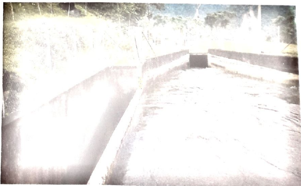
Ingreso del agua al canal de conducción
